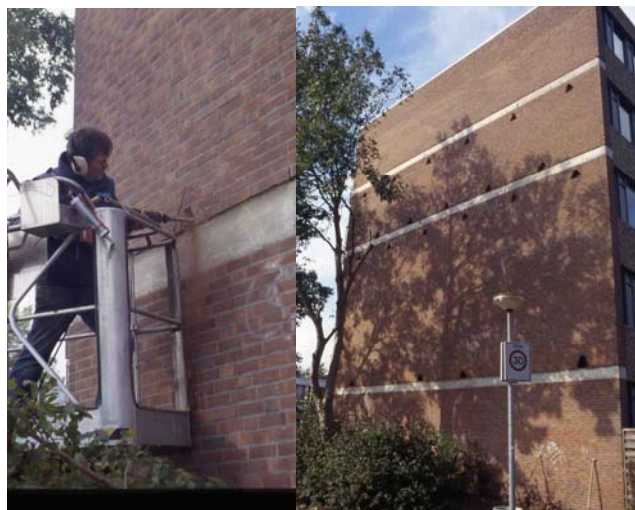
Gaten in muur sloop flat Groningen
