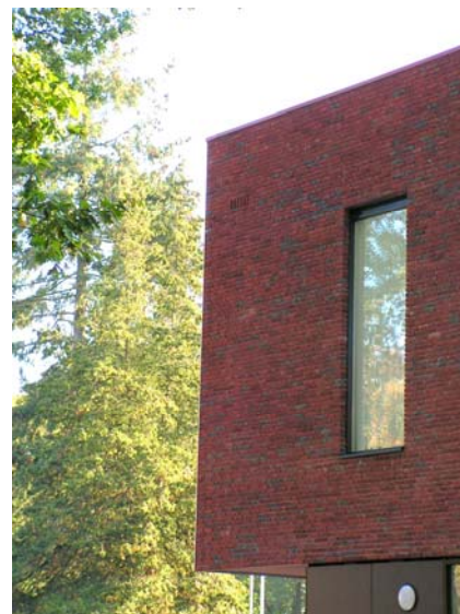
Foto 4 Rollaag boven penant westzijde blok 5
