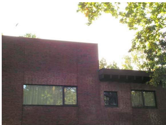
Foto 3 Rollaag boven penant westzijde blok 5
