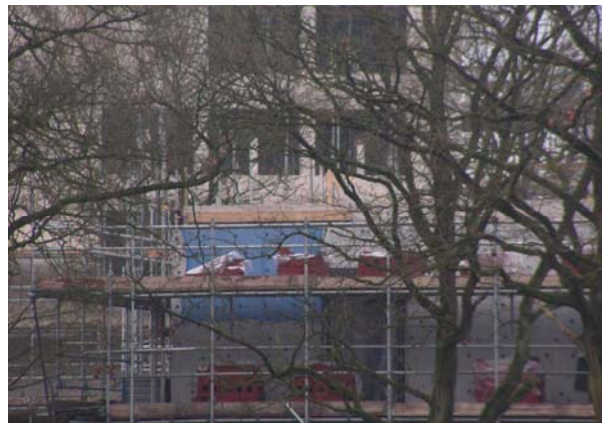
Foto 2 Oostzijde blok4, gaas wordt aangebracht
