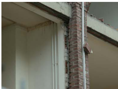
Foto 12 Door strippen kozijn wordt spouw in penant geopend
