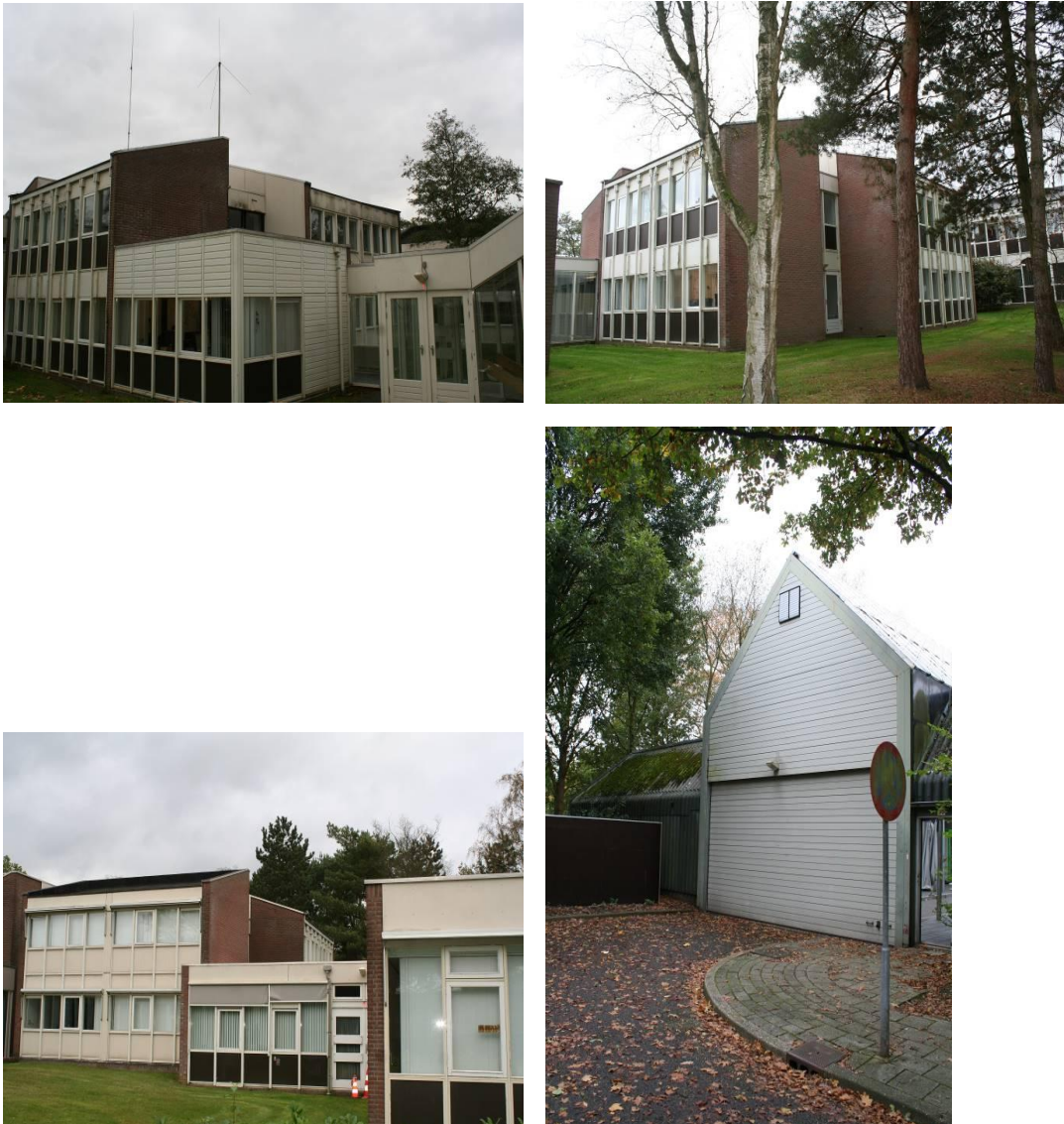
Figuur 5: Foto's van een tweetal locaties waar stootvoegen worden angebracht / opengemaakt (bovenste foto's, linksboven maatregelnummer) en waar vleermuiskasten van Schwegler zijn geplaatst (onderste foto's). De onderste foto geeft een deel van de PPO (de zwarte gevelplaten zijn de asbesthoudende platen).
