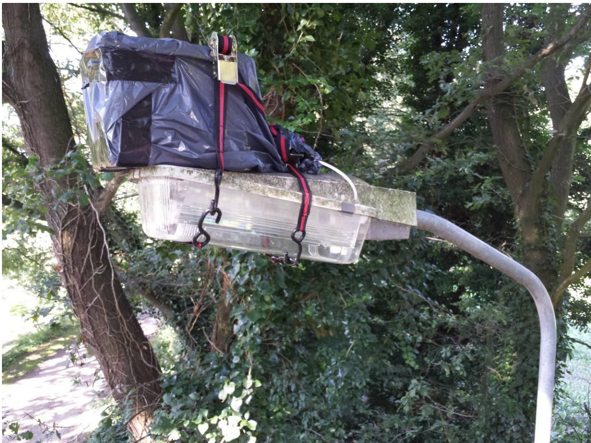
Figuur 1. Batlogger gemonteerd op lantaarnpaal, zijaanzicht.
